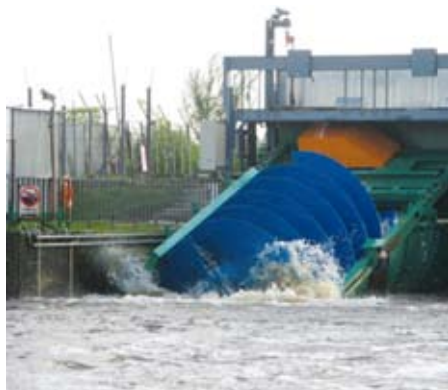
Fot. 11. Mała elektrownia wodna (zastosowanie turbiny ślimakowej); źródło: CDR Brwinów
