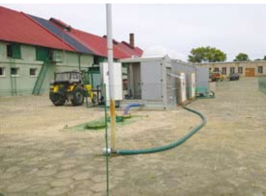
Fot. 7. Mikrobiogazownia kontenerowa 30 kW; źródło: Firma Mega Bełżyce Lublin
