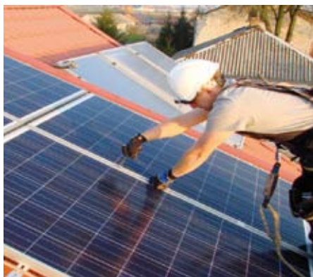
Fot. 10. Panele fotowoltaiczne – montaż na budynku mieszkalnym; źródło: firma OPTIMA Białystok
