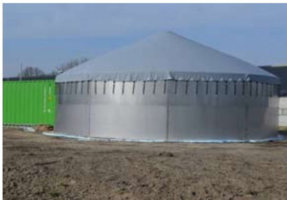
Fot. 8. Mikrobiogazownia na gnojowicę; źródło: Firma Solar Naturalna Energia Wrocław
