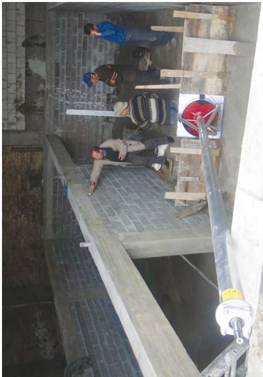
Montaż miksera do mieszania gnojowicy
