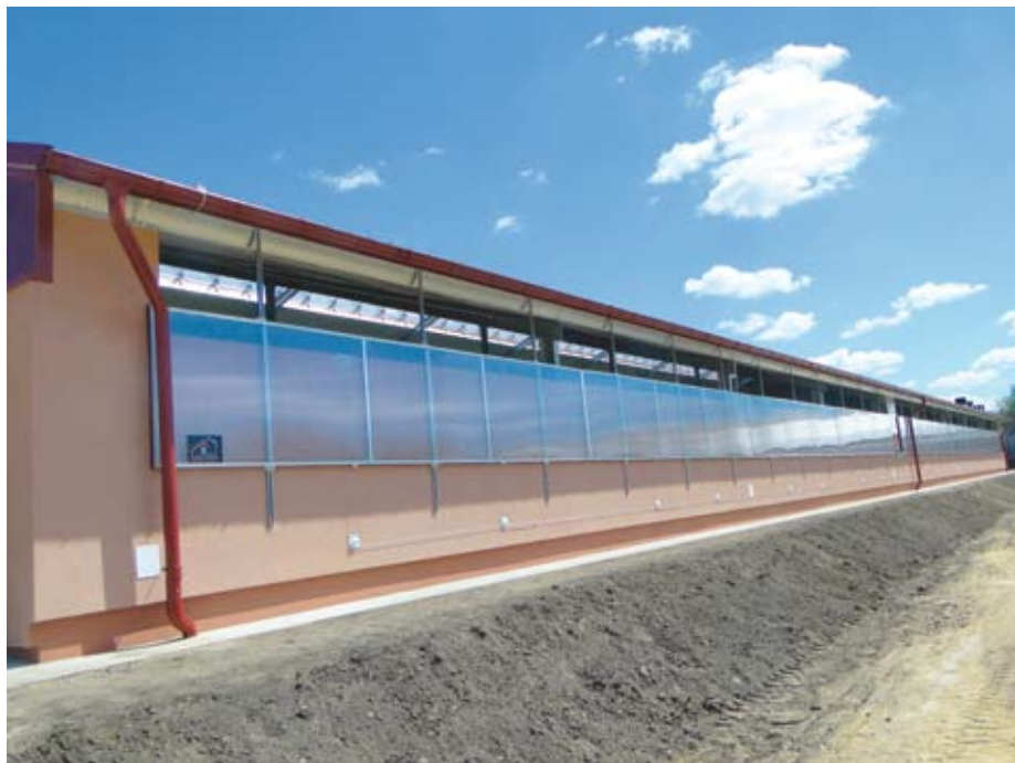
Okna przesuwne regulacji nawiewu powietrza z poliwęglanu komorowego
